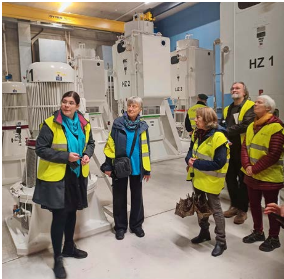
Riesige Pumpen bringen das Wasser zu den Wasserhähnen der Haushalte
